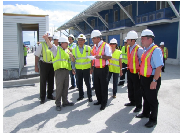
Momento de supervisión de los trabajos en el Muelle Fiscal.
