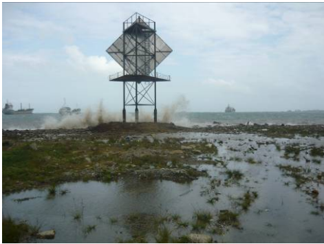
Torre de Enfilamiento A
